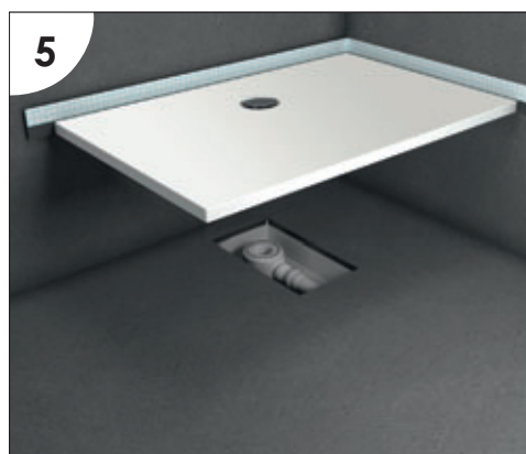
5 Setzen der barrierefreien/ barrierearmen Duschfläche
