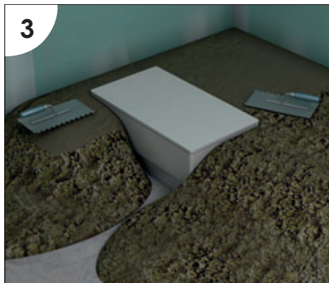
3 Einbringen des Estrichs
